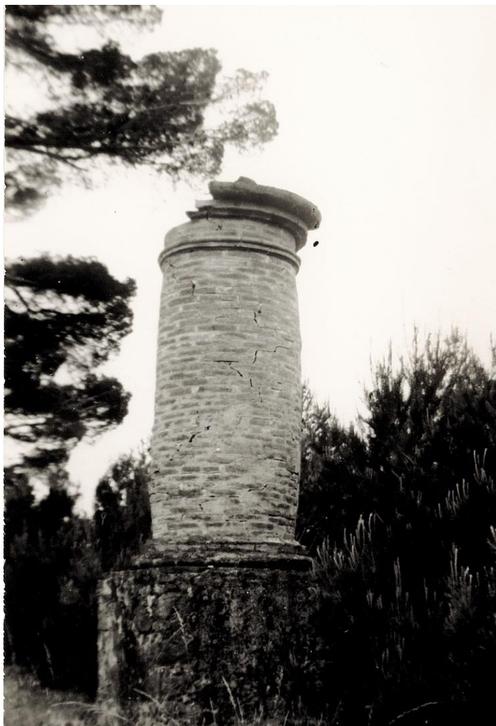
Tour en brique, aujourd'hui écroulée, servant à remonter l'eau de la rivière (photographie R. Martinez, 1966)
