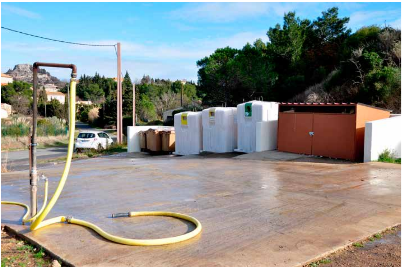
Aménagement du point de collecte sélective «Pech de Gaubert»
